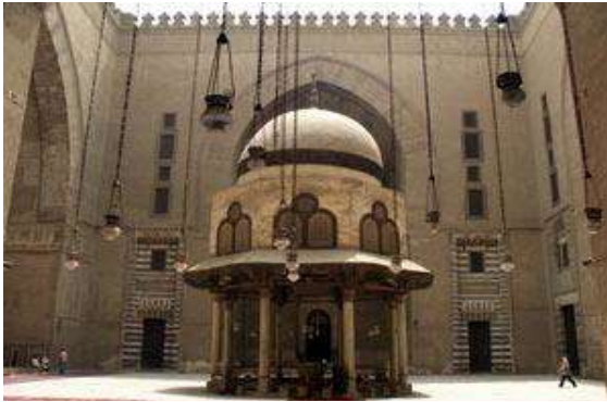
شكل " 5 " نافورة الوضوء مسجد السلطان حسن تحيطها الأواوين الأربعة من جميع الجهات - تميزت بتصميمها الرائع ذو القبة الضخمة المرتكزة على ثمانية أعمدة - أضافت لصحن المسجد تأثير جمالي - وظيفي - بيئي
