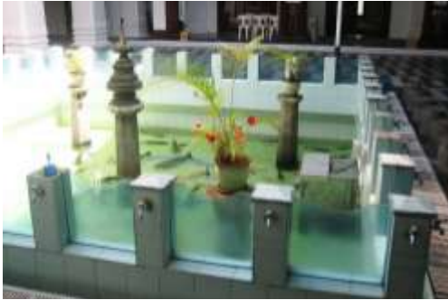
شكل " 28 " مسجد جوماه - نيودلهي - الهند India -New Delhi - Masjid اضافة البعد الجمال للمسجد عن طريق إعادة استخدام مياه الوضوء وتخزين الفائض لري حديقة المسجد
